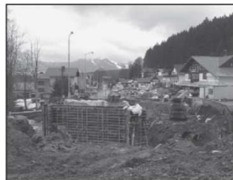
2008 – rekonstrukce mostu na Klatovské ulici byla náročná
