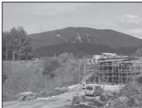
2009 – Budování silniční přeložky ze Železné Rudy na Špičák, která umožňuje průjezd i vysokým vozidlům
