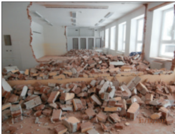
Přesun mateřské školky si vyžádal rozsáhlé stavební úpravy v základní škole
