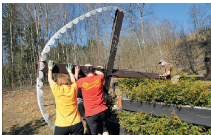
Starý kříž z roku 2002, který byl ve špatném stavu, byl demontován
