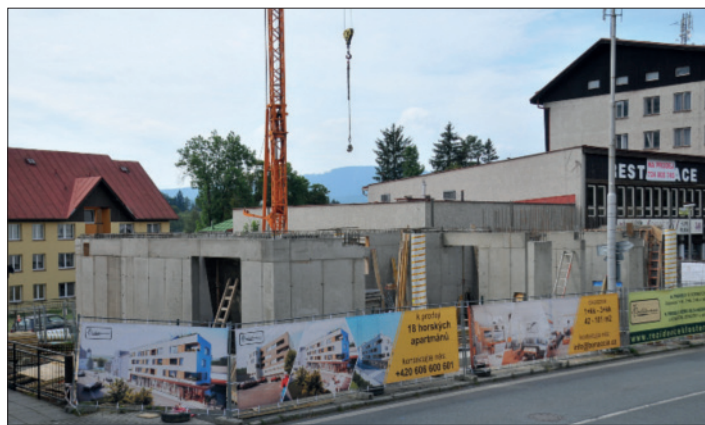
Práce na výstavbě domu na Klostermannově náměstí zdárně pokračuje.
