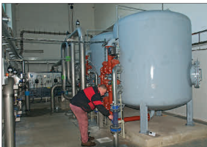
Modernizace městské vodárny a její převzetí do péče města
