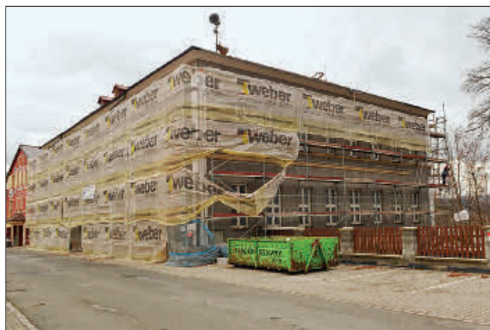
Výstavba Environmentálního centra v Železné Rudě
