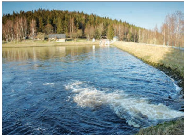
Akumulační nádrž Sedlo, kde se přitékající voda z plavebního kanálu (vpravo dole) shromažďovala a v době provozní špičky v elektrárně vypouštěla.
