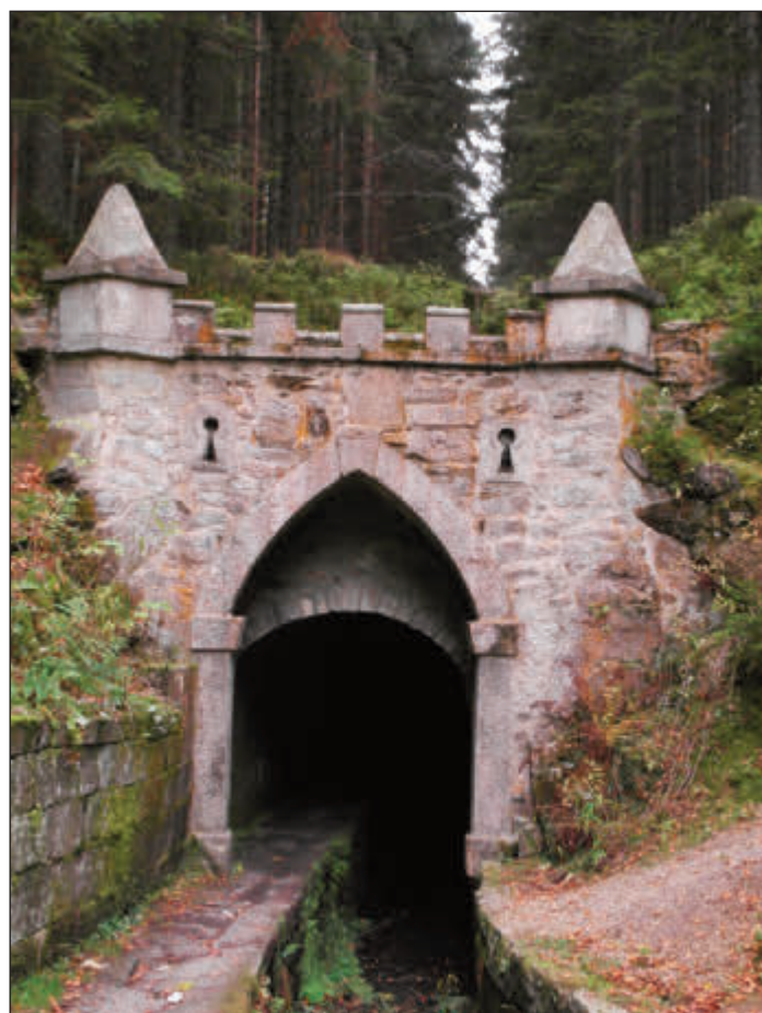
Zde, nedaleko kaple J. Rosenauera, tvoří kanál zajímavou "křižovatku". Vpravo je nadzemní dřevěné koryto.
