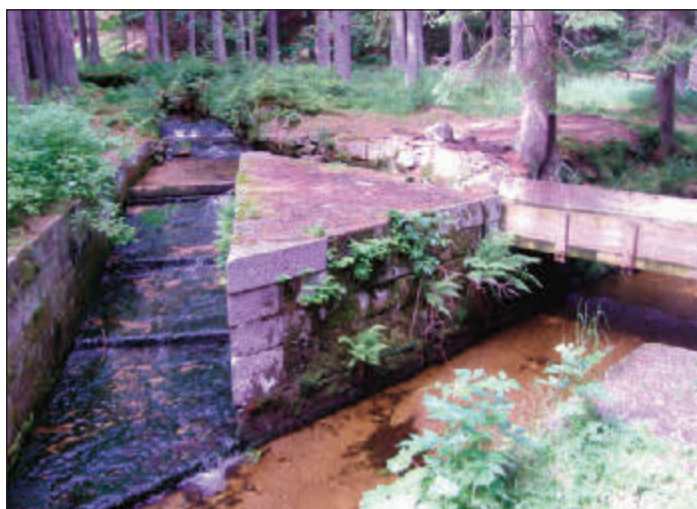
Horní portál, mistrovské stavební dílo, zde voda vtéká do 400 m dlouhého tunelu.
