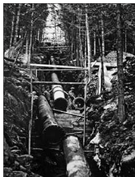
Do ručně vykopaných příkopů ve strmém svahu se muselo položit ocelové přírubové potrubí, dlouhé 1007 metrů.
