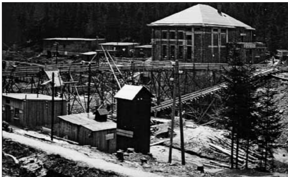
Stavba údolní elektrárny s přehradou na řece Úhlavě započala v roce 1929.
