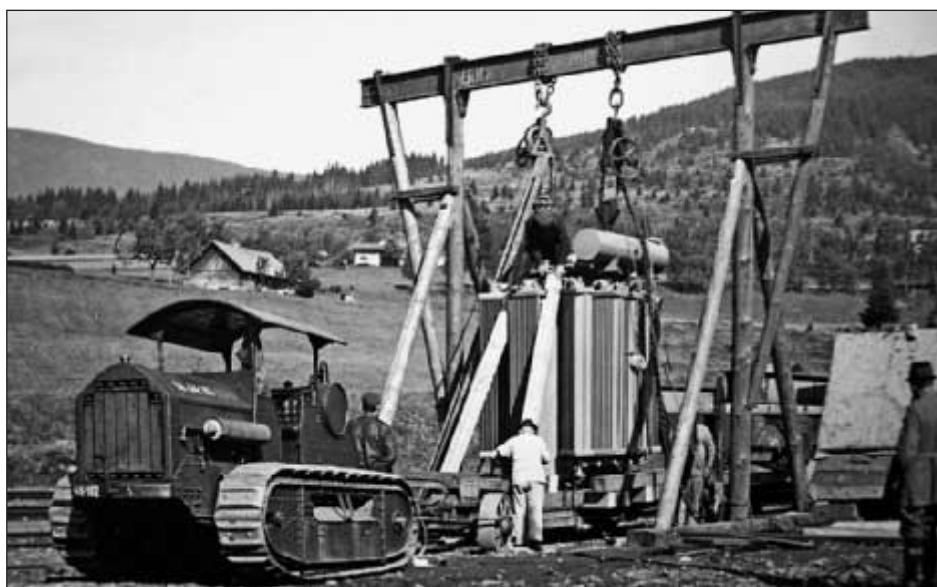
Mnohatunový transformátor byl přeložen na Špičáku z nákladního vlaku na speciální valník.
