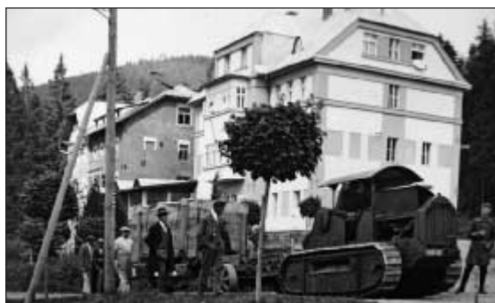
Veškeré komponenty do strojovny elektrárny, ocelové potrubí i montážní materiál se musely z nádraží přes Špičácké sedlo dopravit do Hamrů. V pozadí bývalý hotel Prokop.
