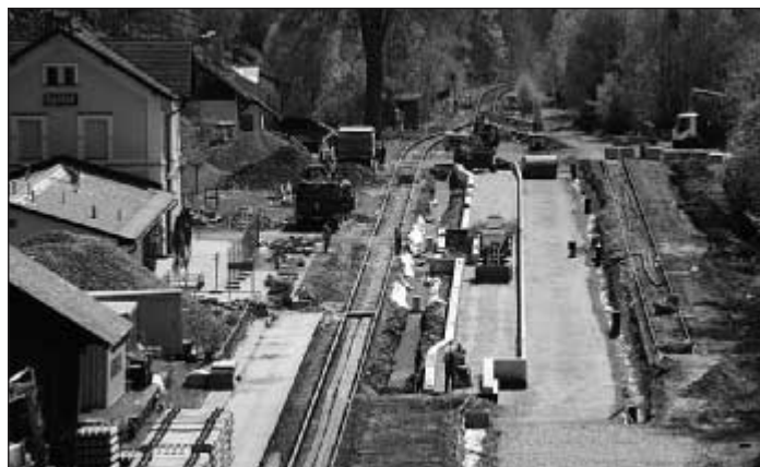
Rekonstrukci také prochází nádraží. Ať na Špičáku, nebo v Alžbětíně. Jsou budována nová nástupiště, rekonstruována kolejiště nebo zabezpečovací systémy.
