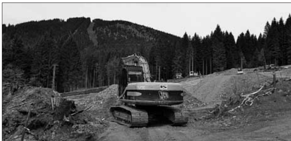
Na vybudování parkoviště pro návštěvníky areálu Špičák se pilně pracuje
