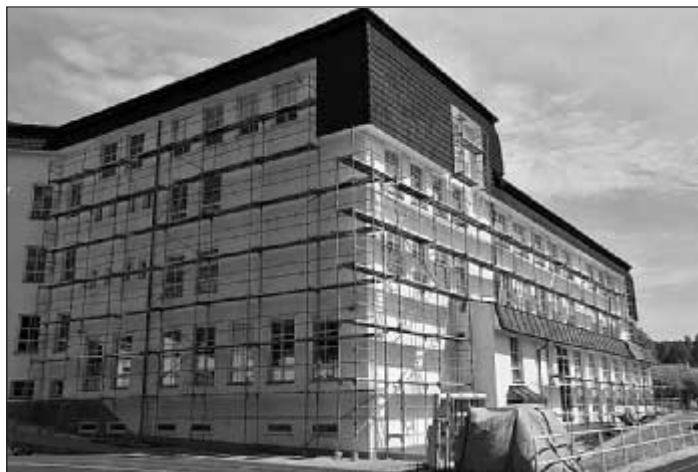
Rekonstrukce základní školy je v plném proudu. Výměna starých oken, dveří a zteplení budovy vyjde na více než 9 milionů korun, ale velkou část zaplatí dotace.
