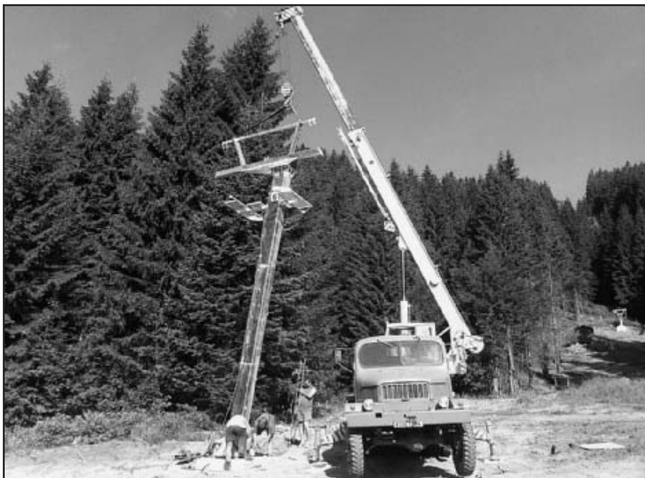
Výstavba lanovky – areál Špičák
