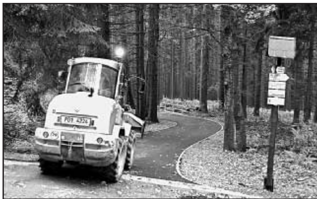
Budování cyklostezek na území Železné Rudy je významný projekt, přínosný pro rozvoj turistického ruchu na Železnorudsku
