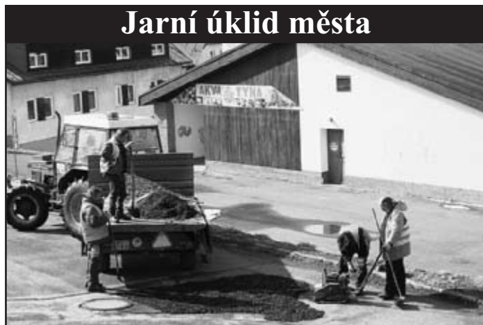
Zaměstnanci Správy, údržby, dopravy města Železná Ruda opravují po zimě výtluky na vozovce
