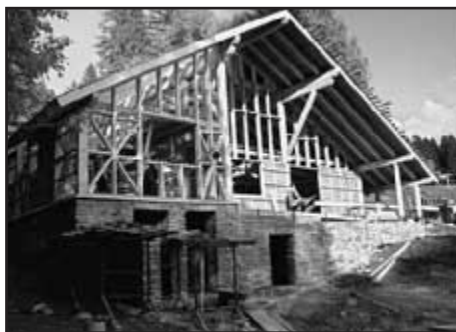
Nosnou konstrukci domu tvoří KVH hranoly – výstavba domu na podzim roku 2008
