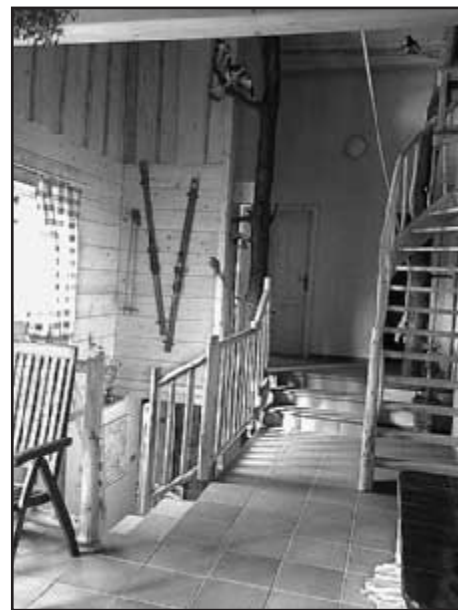
Dva dubové kmeny podírají nosné trámy domu
