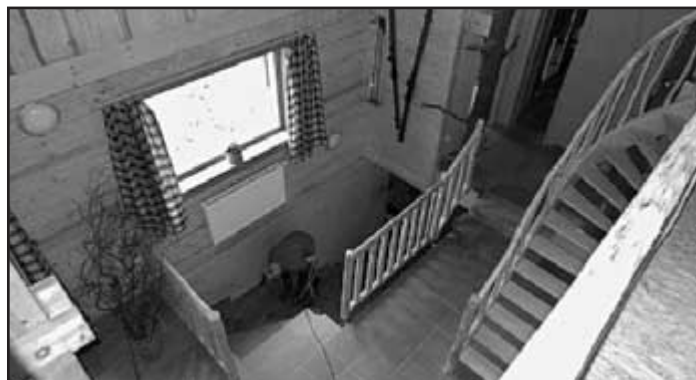
Pohled z podkrovní. Zábradlí jsou zhotovena ze smrkových větví, částečně ze stromu, který porazil soused Jana Šabaty
