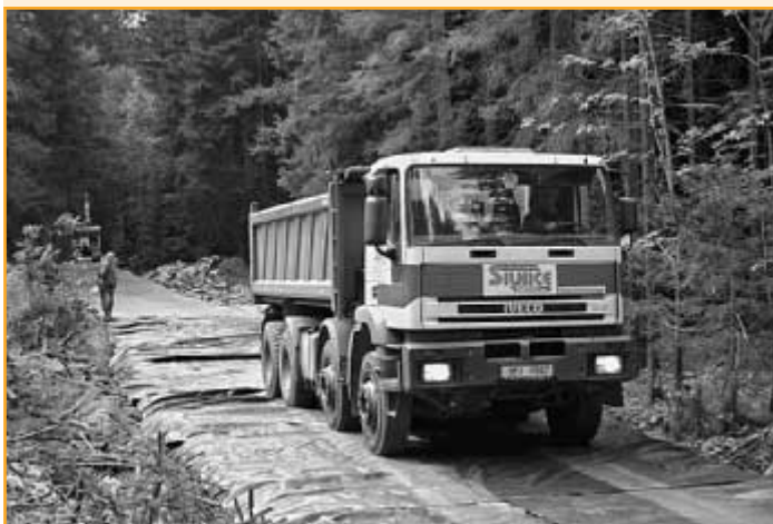
Práce na nové stezce pro pěší a cyklisty mezi Špičákem a Železnou Rudou
