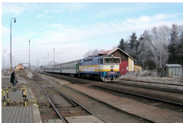
Železniční stanice Nýrsko před rekonstrukcí.
