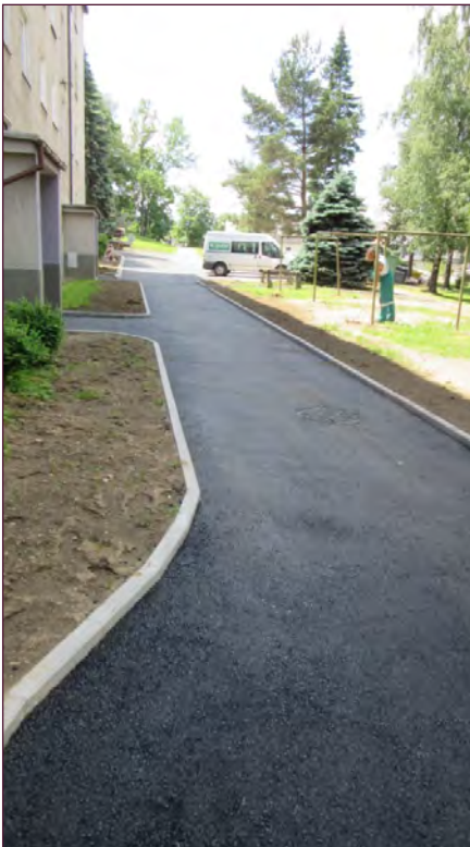
Parkoviště u čísla popisného 680 a 681 bylo dokončeno. Zároveň byly odstraněny nedodělky včetně odvodnění plochy. Zhotovitel Silnice Nepomuk.
