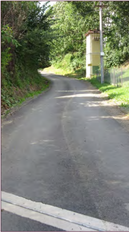
Na komunikaci Starý Láz - Hodoušice byla dokončena poslední etapa oprav.
