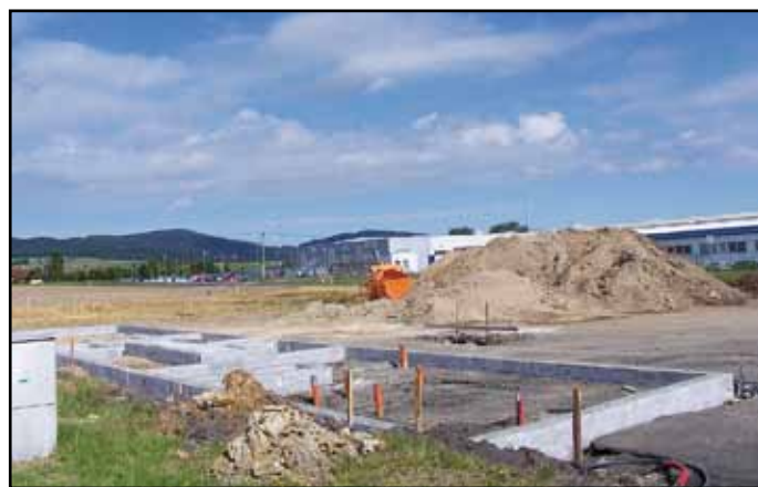
Práce na stavbě ledové plochy pokračují.
