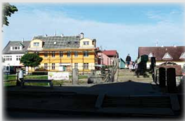
Most s jezem přes řeku Úhlavu dříve a nyní.
