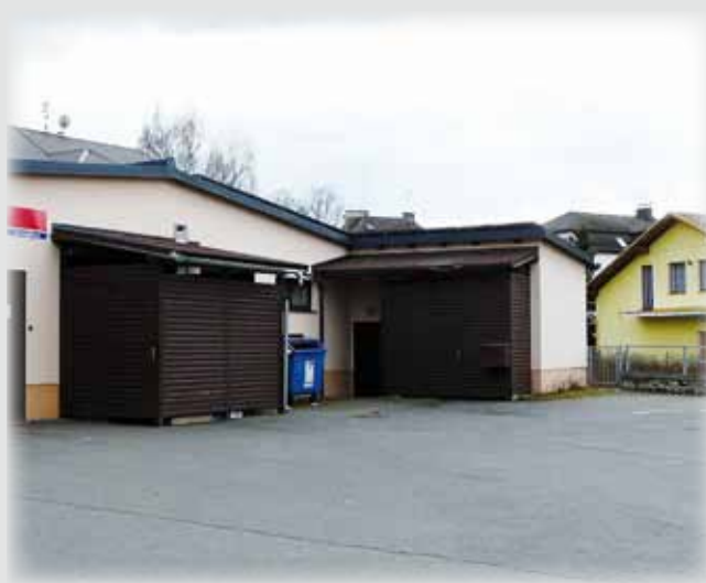
Nýrská synagoga při demolici na snímku Hynka Pulánka z roku 1957 a dnešní Rybářská ulice, kde synagoga stávala.
