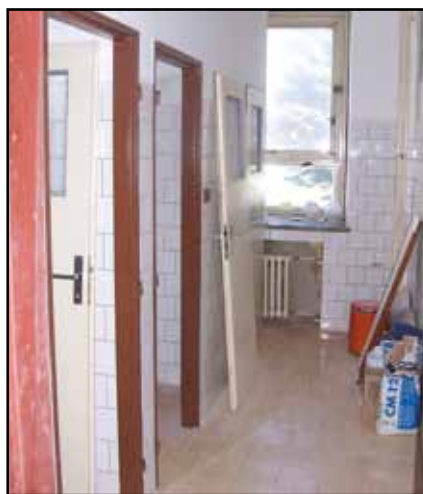
Pokračující rekonstrukce WC v kulturním domě.
