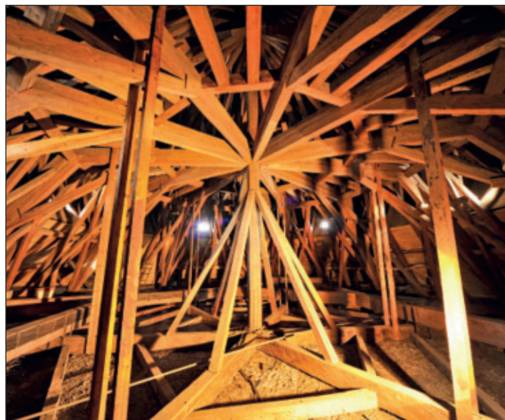
Zrenovovaný krov kostelní věže
