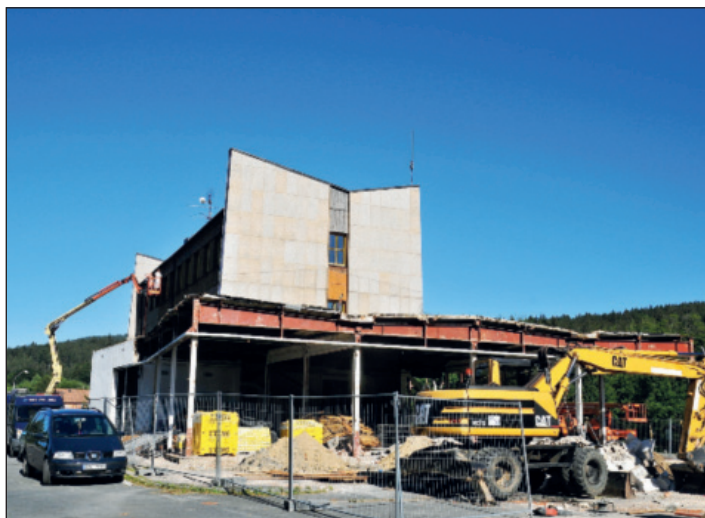
Začala přestavba staré celnice na komerční účely.
