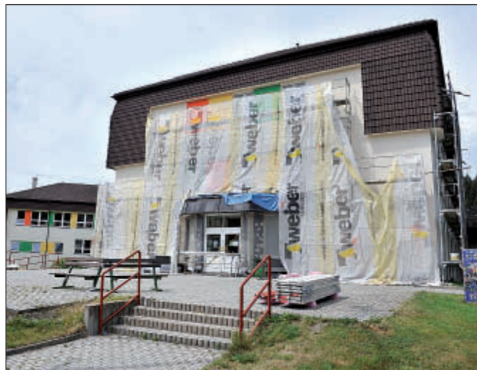
Stavební práce na fasádě základní školy pokračují dle plánu. Školáci spatří svoji školu v novém hávu již počátkem září.
