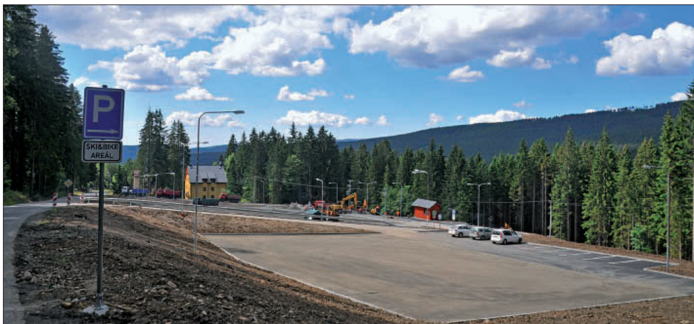
Parkoviště pro sportovní areál je již před dokončením.
