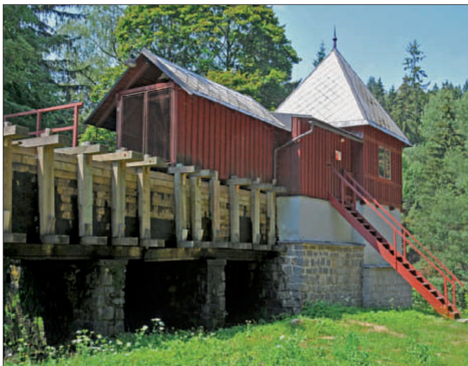
Vantroky na pilířích přivádí vodu z kanálu do turbíny, která se nachází v kamenné kádi pod jehlancovitou střechou
