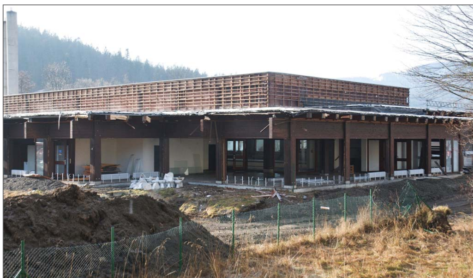
Smutný konec postihl krytý bazén v Bavarské Rudě, který se nachází v demolici.
