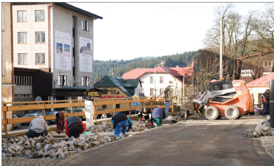
Dokončovací práce na novém parkovišti před radnicí. Místo zámkové dlažby bytelná žulová.
