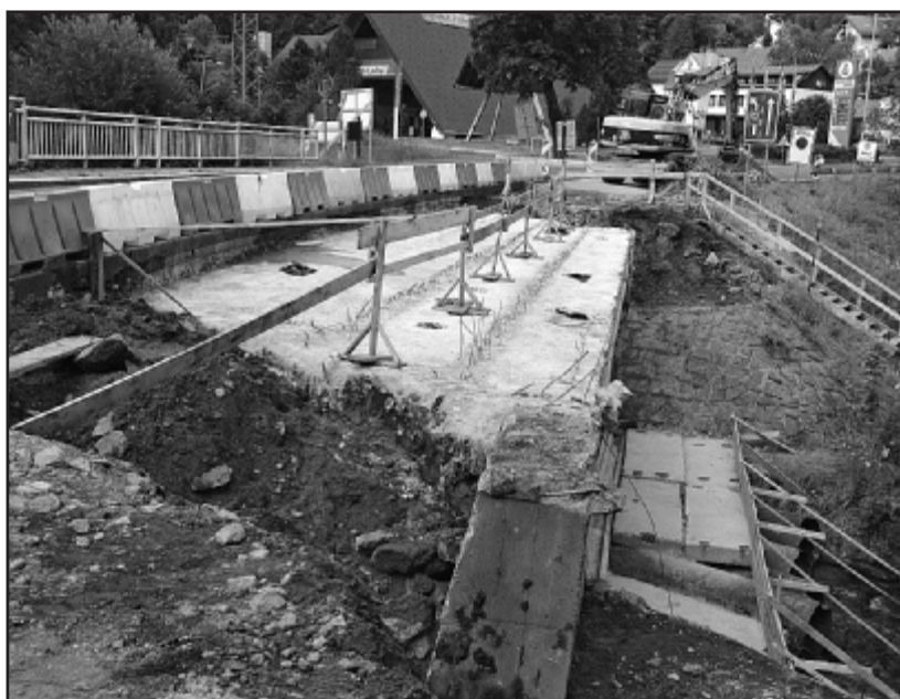
Náročná rekonstrukce mostu u benzinové pumpy si vyžádá ještě nějaký čas strpení, než bude stavba dokončena
