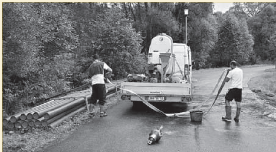
Při pokládání nového potrubí pitné vody v Alžbětíně se museli stavaři prorazit i pod povrchem vozovky
