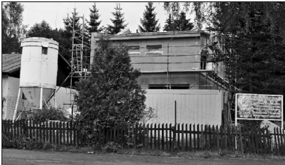
Stavba výjezdního místa Záchrany zdravotní služby je před dokončením
