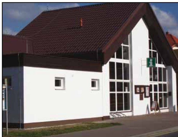
Zrekonstruované WC u informačního centra na autobusovém nádraží.
