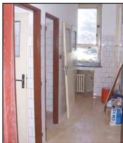
Pokračující rekonstrukce WC v kulturním domě.
