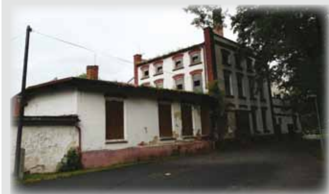
Budova čp. 199 - Okula, závod II., v roce 1953 a v současné době.
