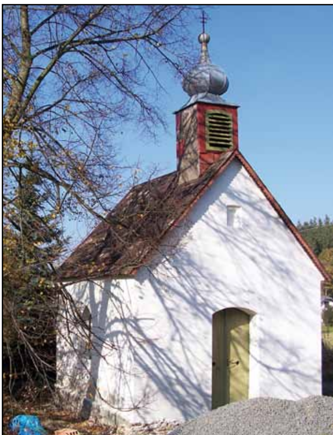
Probíhající rekonstrukce kapliček v Blatech a Staré Lhotě.
