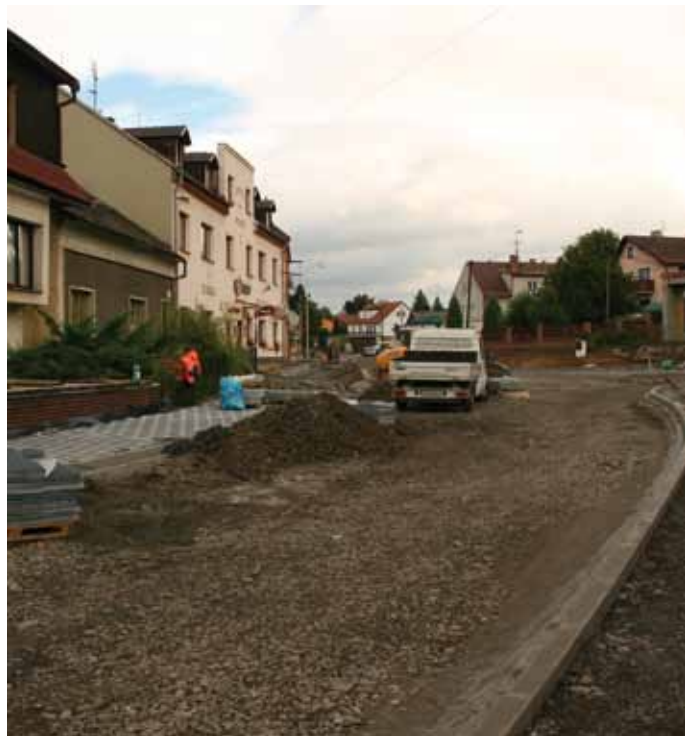
Práce na druhé etapě rekonstrukce Klatovské ulice - srpen 2010.
