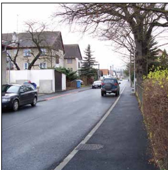
Husova ulice po rekonstrukci.
