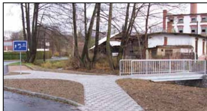
Nová lávka přes náhon - ve výstavbě a po dokončení.
