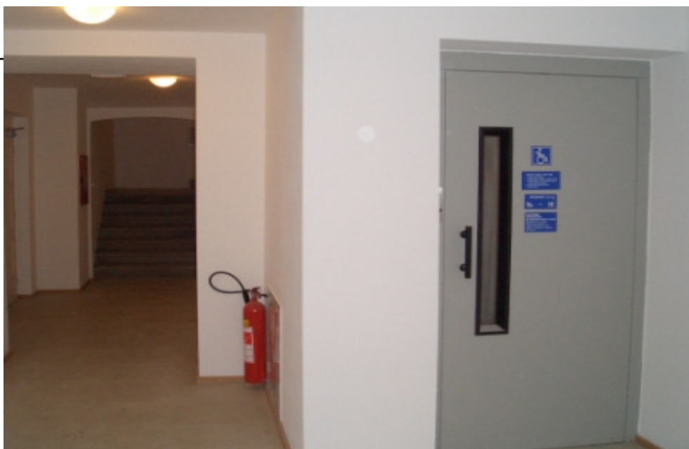
Bezbariérový přístup - výtah
